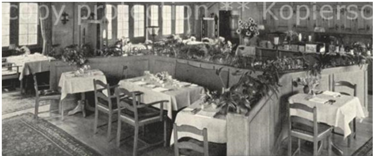
Rest. Haus zum Rügen, Limmatquai 42, 8001 Zürich
